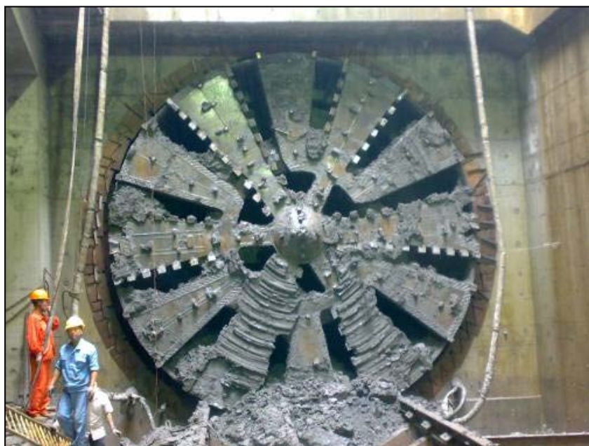
图1.0.3-1 盾构冰冻法进洞照片
