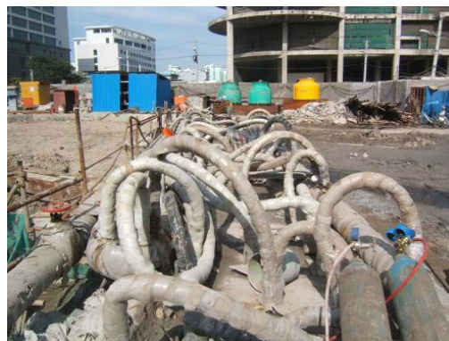
图 5.2.5-1 积极冻结施工照
