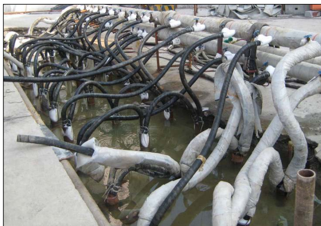
图 11.2.1-1 冰冻法施工照片
