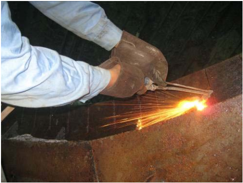
照片 5.2.7-3 泥沙阻止装置弹性钢板上割缝
