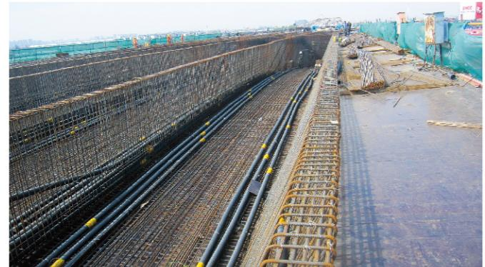
宏润建设宁波公司承建的宁波市北环快速路工程VI标段项目，其中跨G329国道为三跨连续预应力现浇箱梁，为目前宁波市采用满堂支架法施工跨径最大的现浇箱梁。三跨连续梁跨径布置为42m+72m+42m，中横梁部位箱梁混凝土高度更是达到了4.5m。
