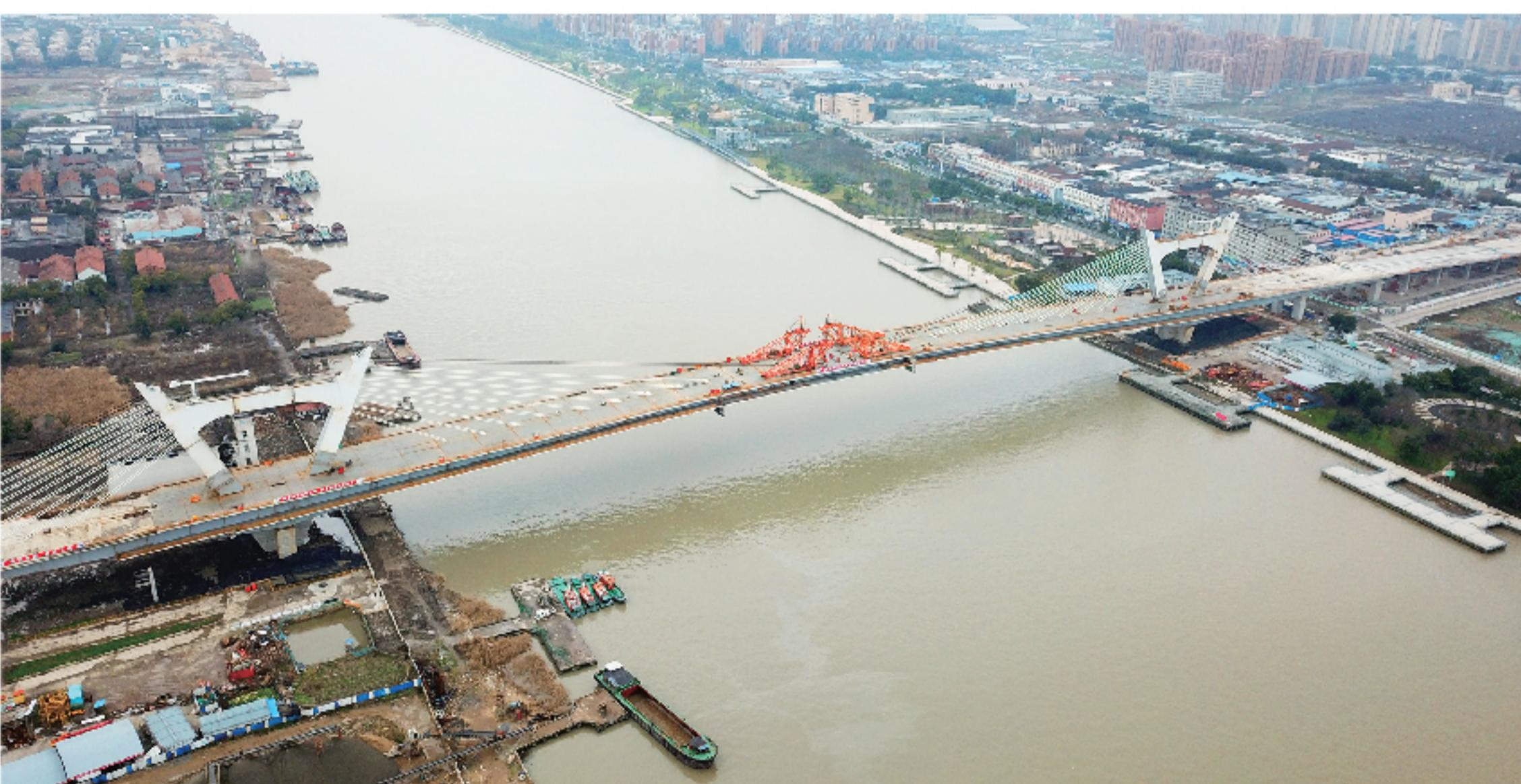
值得一提的是，中兴大桥中跨无索区长度达到了96米，中跨超长无索区的线形控制具有很大的技术难度，且无先例可供参考。为了最后合龙施工，项目部连续备战了三十多个昼夜，临近合龙的这几天更是全天不间断的观测和监控合龙口状况，选择最佳时机进行合龙段的配切及安装，确保合龙工程顺利完成。
