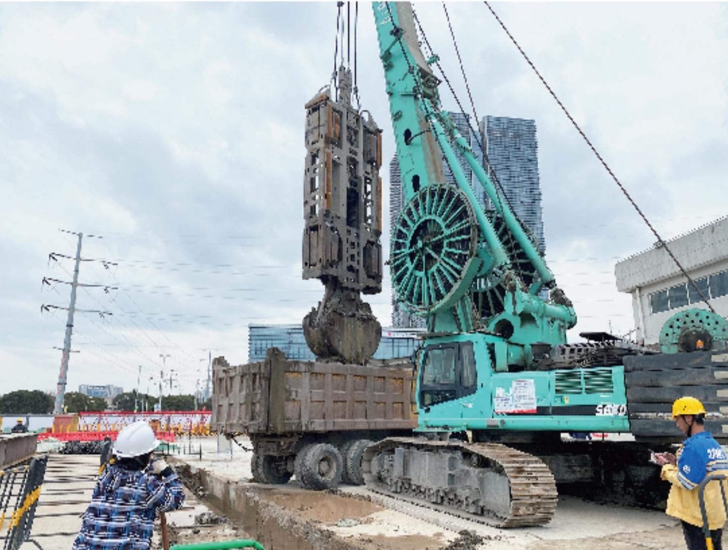
2021年3月5日，伴随着两台履带吊的缓缓提升，由宏润苏州公司承建的苏州轨道交通7号线VII-TS-06标土建施工通园路站首幅地下连续墙顺利开工。
